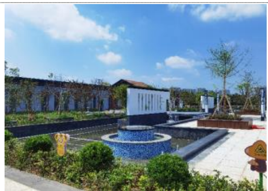
南昌市新建城地下生态水厂（2 万吨/天）
