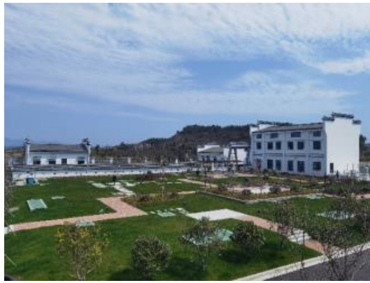
九江市武宁县水生态循环净化处理厂（2万吨/天）
