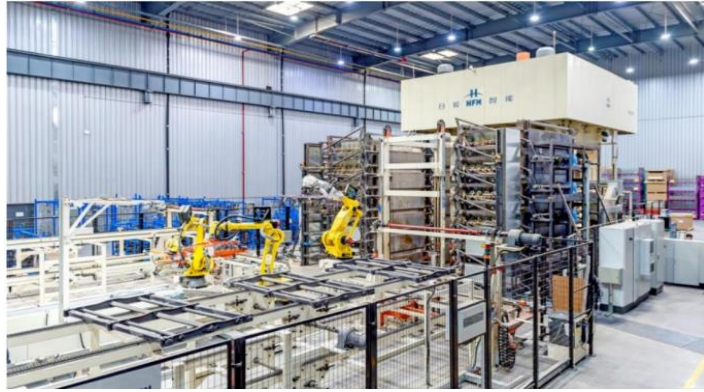
超高强钢间接热冲压成形生产线
