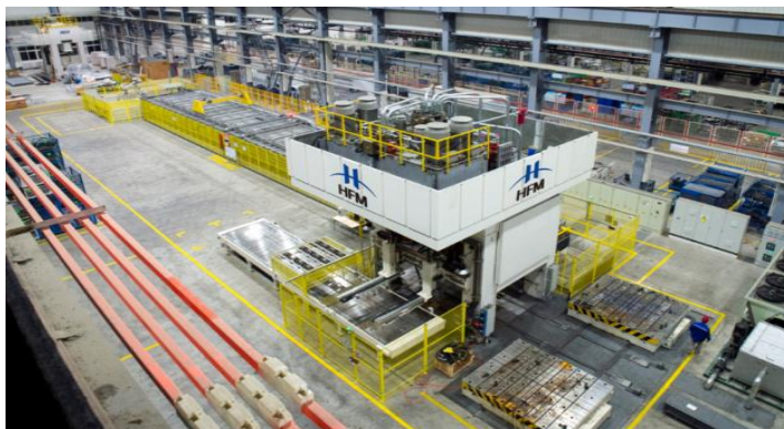
超高强钢直接热冲压成形生产线
