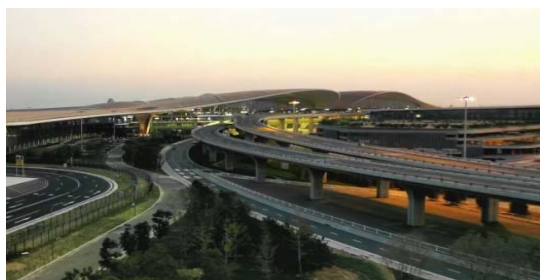
北京大兴国际机场路灯项目
