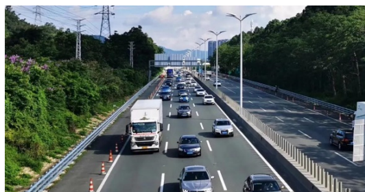
广深高速深圳段路灯项目
