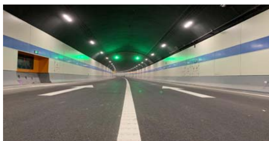
湖南常德沅江隧道工程项目
