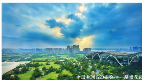
中国杭州G20峰会——屋顶花园
