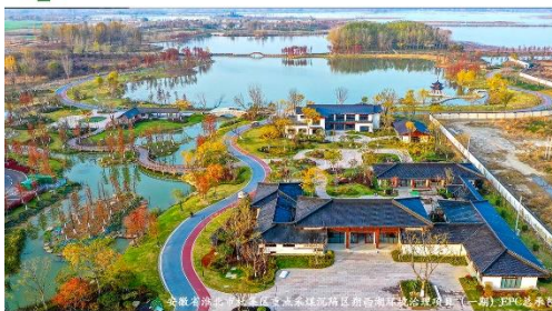
安徽省滁州市天长市森林湿地公园景观提升工程（一期）EPC总承包
