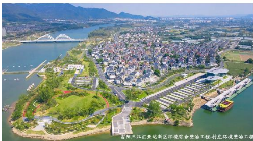
富阳三江汇进新区环境综合整治工程-村庄环境整治工程
