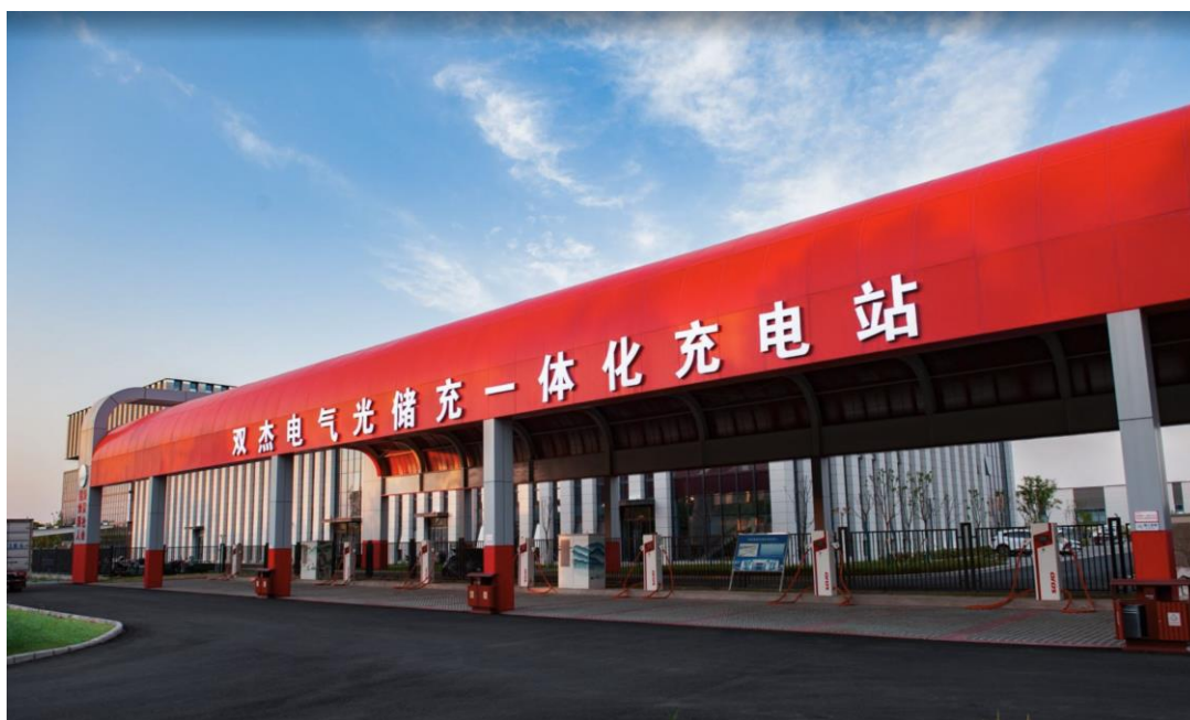
合肥光储充（换）一体化示范项目
