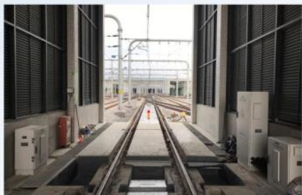
列车360度外观故障检测系统
