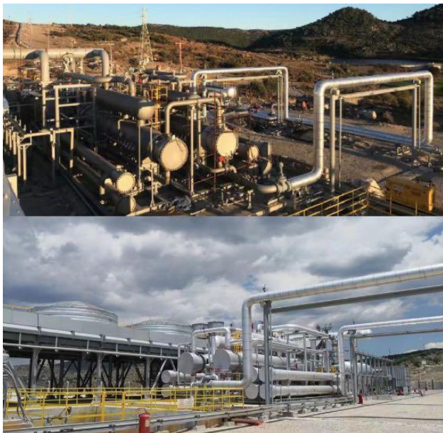
Transmark 项目全景图
