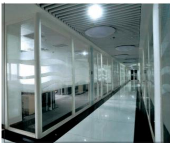
钢制防火玻璃门及隔墙
