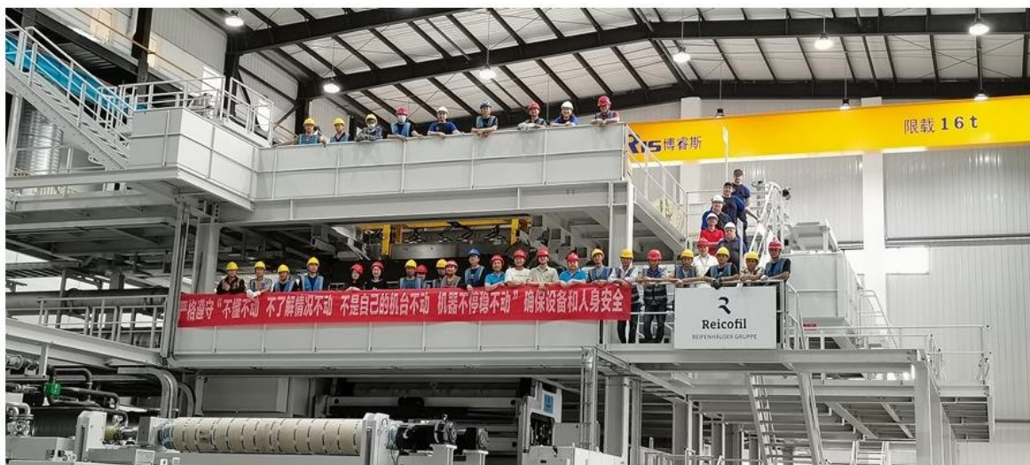
图：感控项目部分进口设备完成安装
