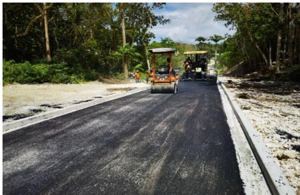
巴巴多斯苏格兰地区道路修复项目
