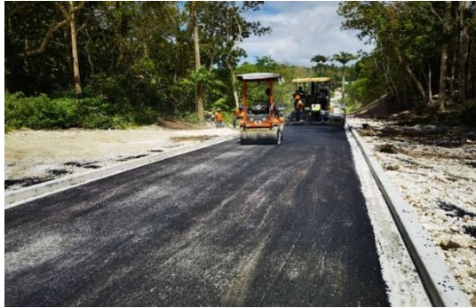
巴巴多斯苏格兰地区道路修复项目
