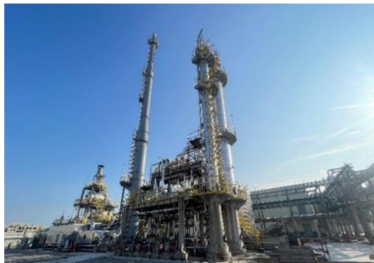
浙石化废气废液焚烧系统
